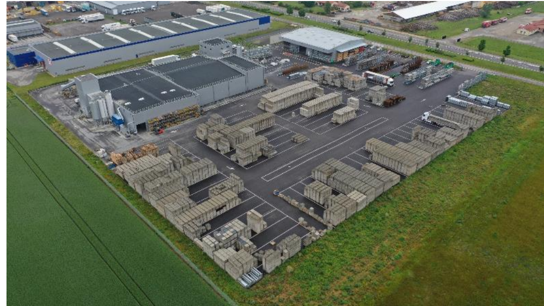
Usine de préfabrication de bloc de béton de Viriville (38)
